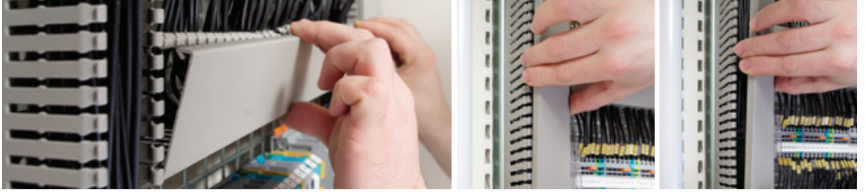
Kablo Kanal Kapağı Uygulama
